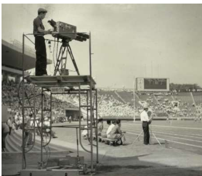
競技場での放送施設
